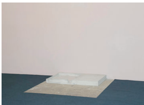
Určíte umiestnenie krbu a zakresíte obrysy. (1)
