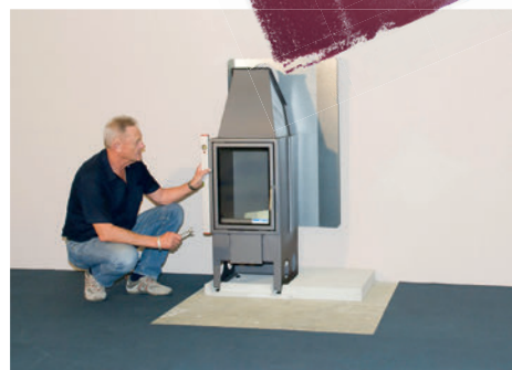
Osadte krbovú vložku pomocou vodováhy. (3)
