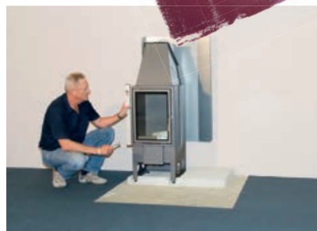
Osadte krbovú vložku pomocou vodováhy. (3)
