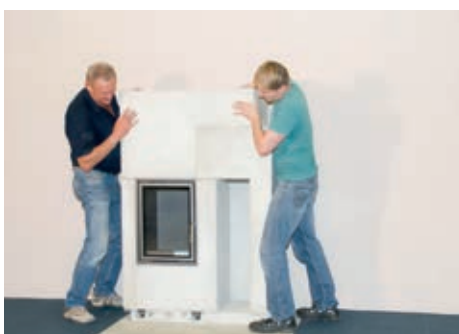
Jednotlivé diely stačí poskladať podľa priloženého návodu. Upevnite akrylátovým lepidlom. (4 + 5)
