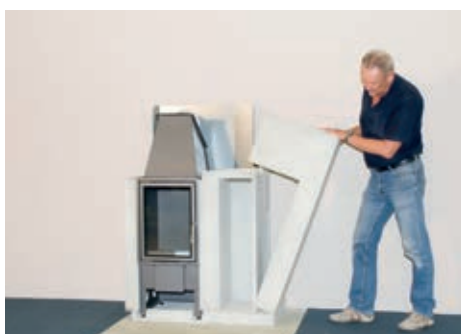
Jednotlivé diely stačí poskladať podľa priloženého návodu. Upevnite akrylátovým lepidlom. (4 + 5)
