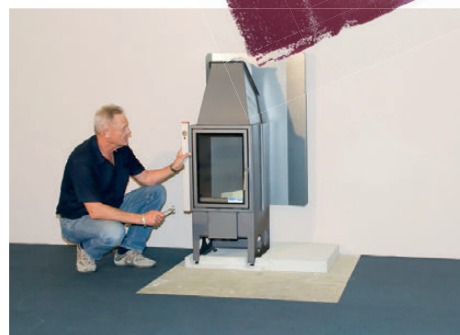
Osadte krbovú vložku pomocou vodováhy. (3)
