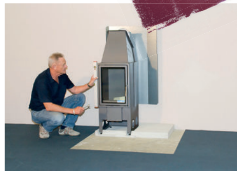
Osadíte krbovú vložku pomocou vodováhy. (3)
