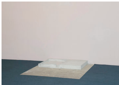
Určíte umiestnenie krbu a zakresíte obrisy. (1)
