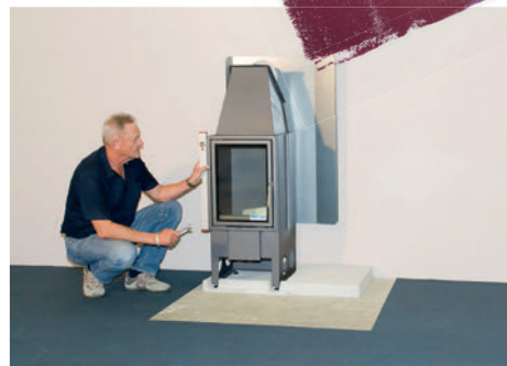
Osadíte krbovú vložku pomocou vodováhy. (3)
