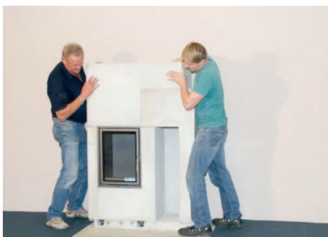
Jednotlivé diely stačí poskladať podľa priloženého návodu. Upevnite akrylátovým lepidlom. (4 + 5)
