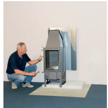
Osadte krbovú vložku pomocou vodováhy. (3)
