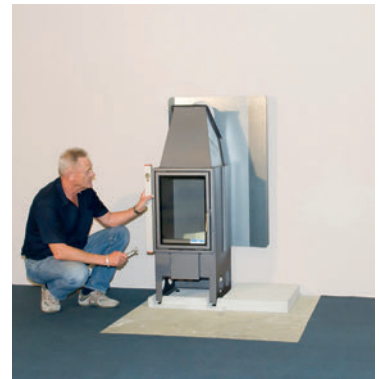
Osadíte krbovú vložku pomocou vodováhy. (3)
