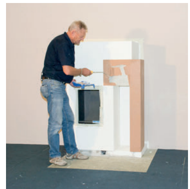
Môžete ju natrieť ľubovoľnou interiérovou farbou. (6)
